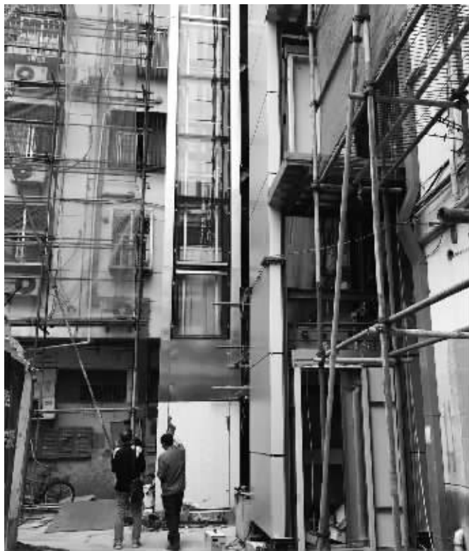
江宁路35号小区正在抓紧安装电梯
